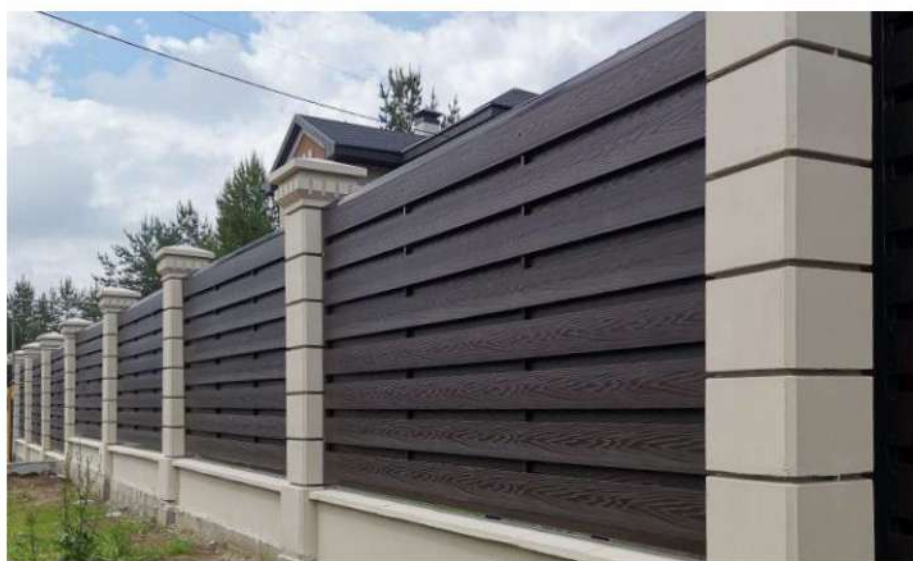
Рис. 1 – Горизонтальное крепление в металлической рамке
